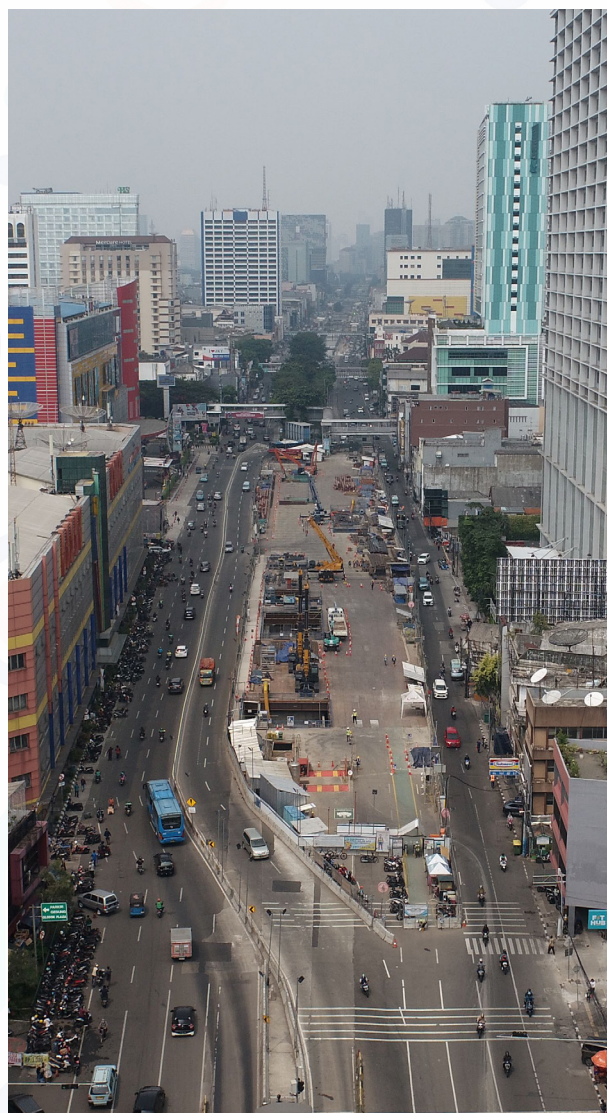
インドネシアジャカルタ MRT CP203 工区 GLODOK 駅における開削工事施工写真
