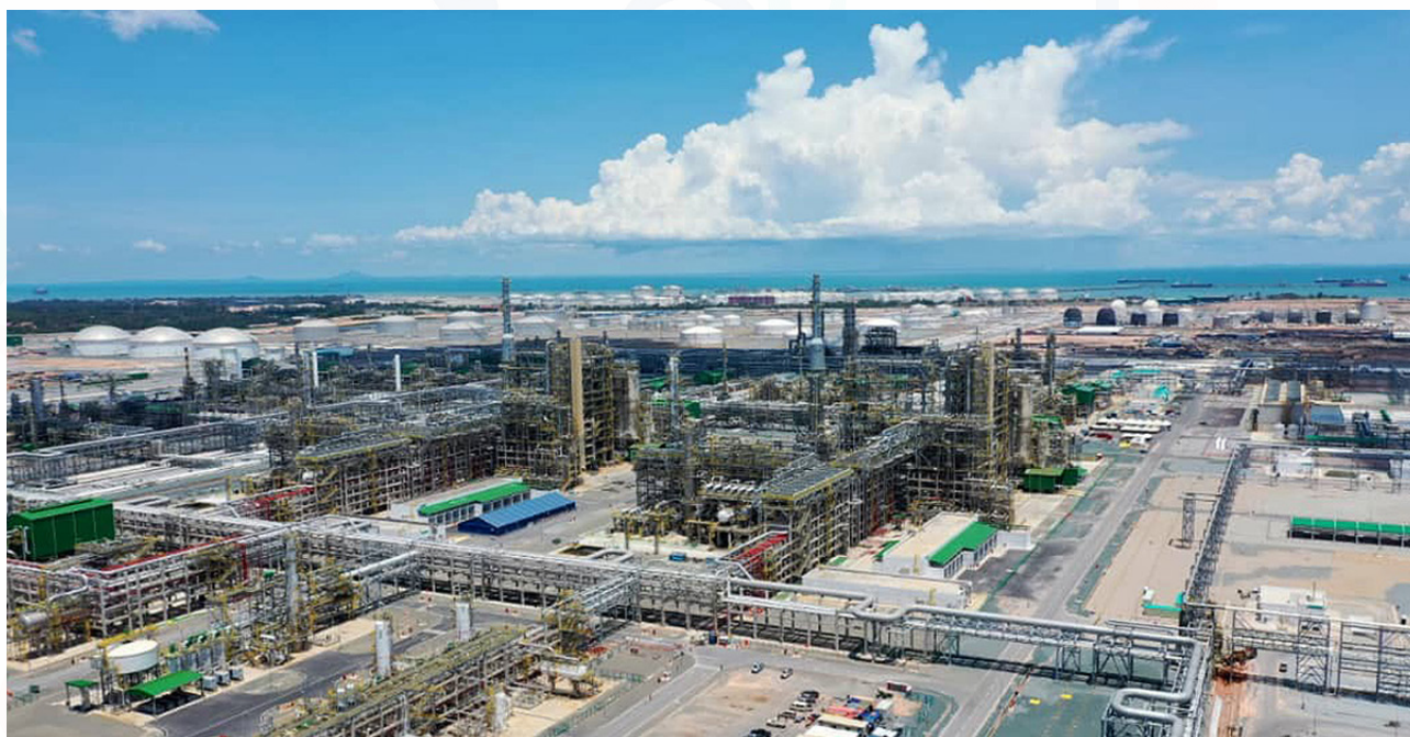
マレーシアの RAPID RFCC プロジェクト
