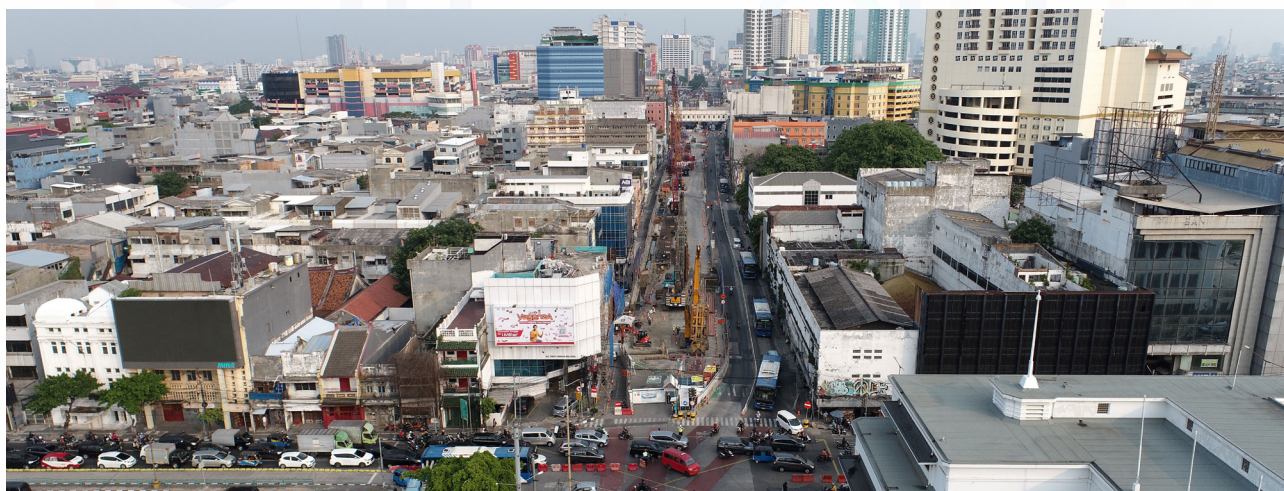
インドネシア ジャカルタ MRT 南北線 (CP203)KOTA 駅における開削工事の施工写真
