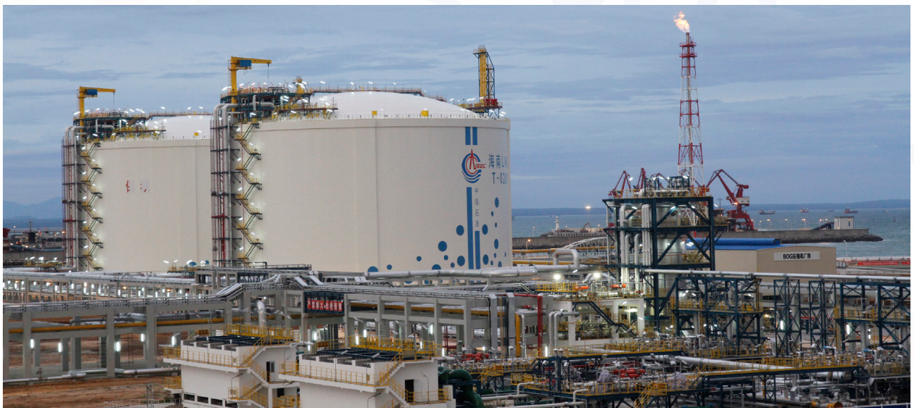
中国海南にある LNG 受入基地
