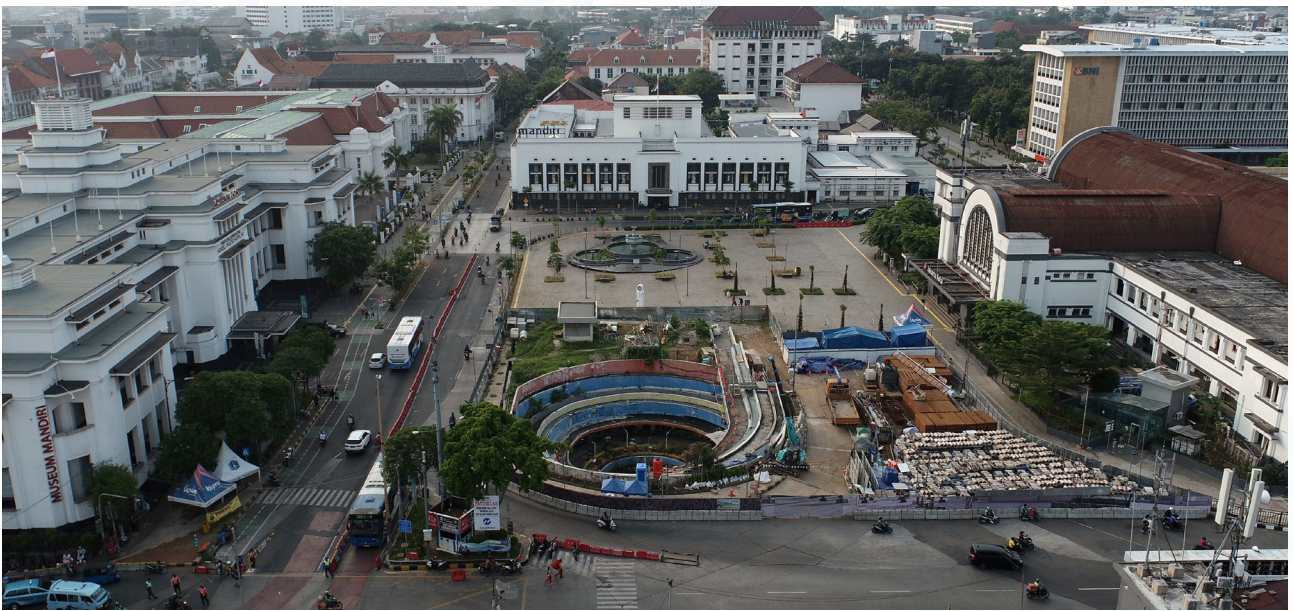
インドネシアジャカルタMRT南北線(CP203工区)TPO駅開削・逆打ち施工写真
