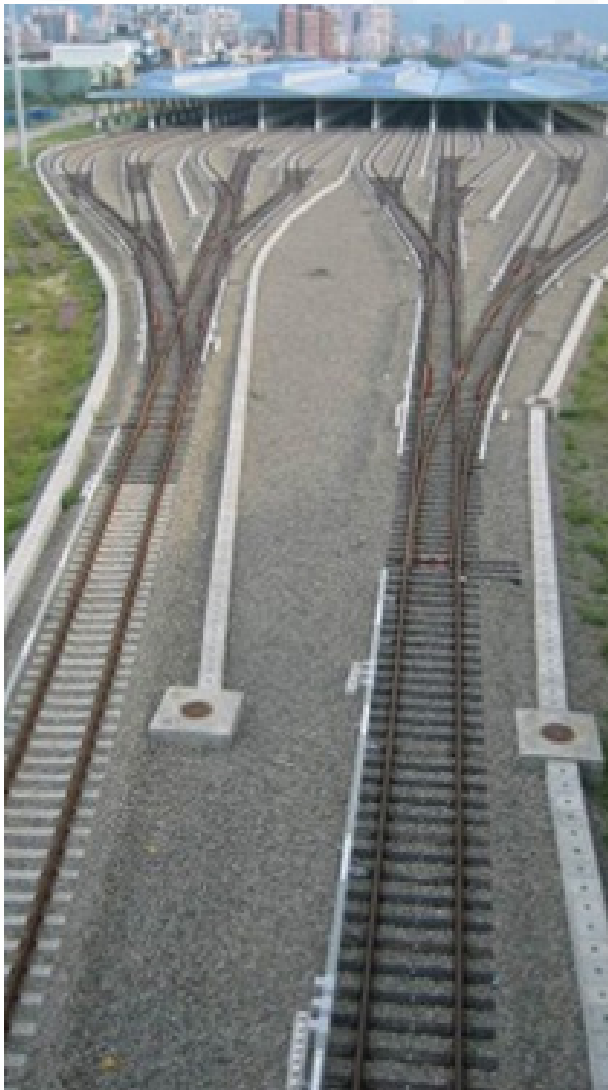
臺北大眾捷運系統土城機廠
