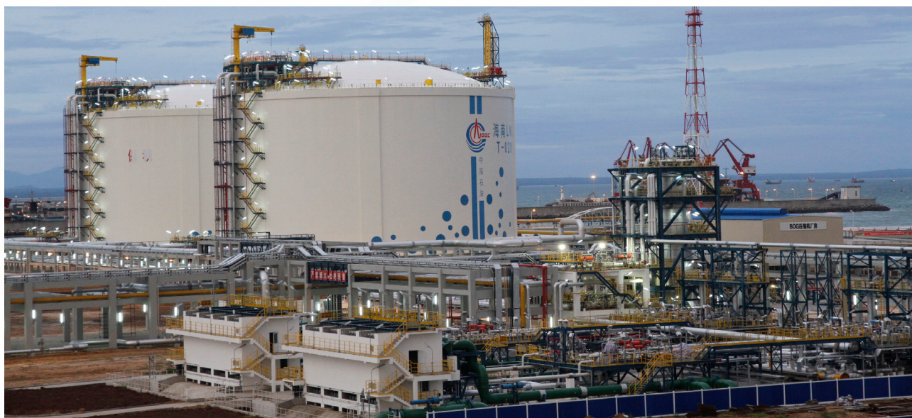
中國海南 LNG 接收站
