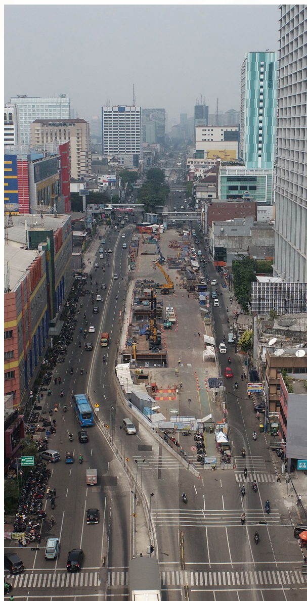
印尼雅加達 CP203 標 GLODOK 站明挖覆蓋施工
