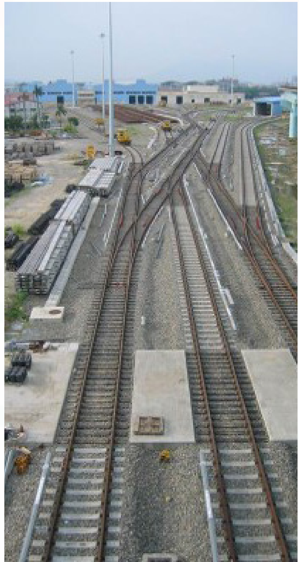
臺北大眾捷運系統土城機廠
