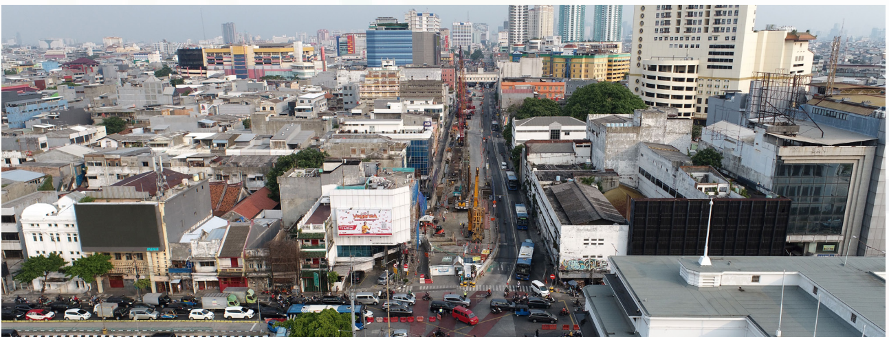
印尼雅加達捷運南北線 (CP203 標) KOTA 站明挖覆蓋施工照片
