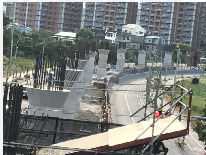
(圖說：龍埔路施工情形) 圖片來源：捷運三鶯線施工團隊
