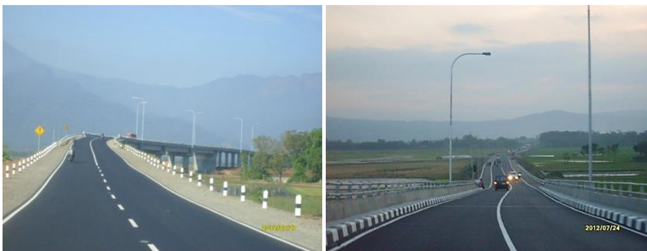
圖 6.3-2 Tambakboyo Bridge 橋梁及樁支撐延長橋版結構 竣工照片
