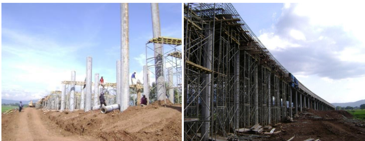
圖 6.3-1 Tambakboyo Bridge 西橋台位置 樁支撐延長橋版結構 施工照片
