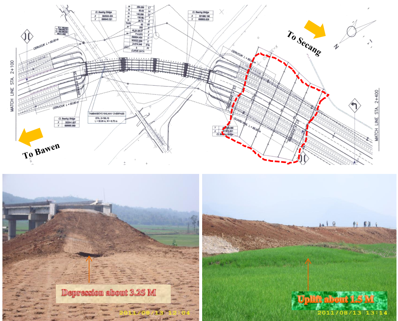
圖 6.1 Tambakboyo Bridge (L = 103 m, STA 2+200) 西側 高橋台進橋位置 路堤塌陷 狀況
