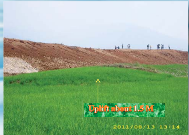
圖6.1 Tambakboyo Bridge (L = 103 m) 西側 高橋台進橋位置 路堤塌陷 狀況
