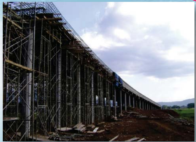
圖 6.2-1 Tambakboyo Bridge 西橋台位置 樁支撐延長橋版結構 施工照片
