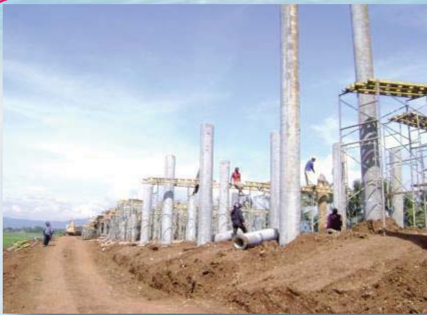
圖 6.2-1 Tambakboyo Bridge 西橋台位置 樁支撐延長橋版結構 施工照片
