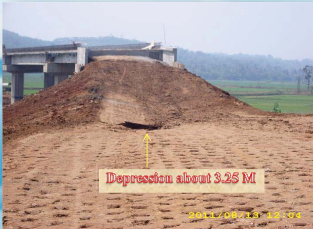
圖6.1 Tambakboyo Bridge (L = 103 m) 西側 高橋台進橋位置 路堤塌陷 狀況
